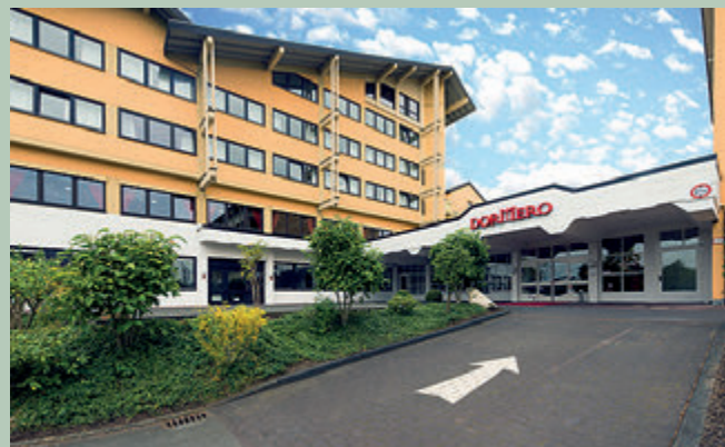
Hotel Dormero, Raum Schlafstube Brunnenstraße 7, Windhagen
